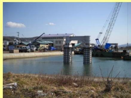
浮棧橋設置箇所整備状況
