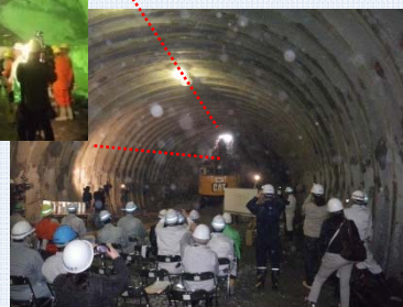
【トンネル貫通の瞬間】
