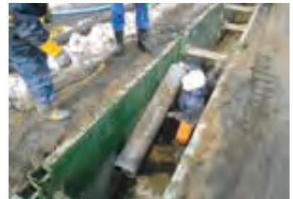
震災で壊れた上下水道管復旧工事の様子
