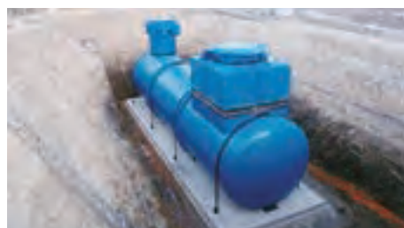
耐震性貯水槽（山下）
