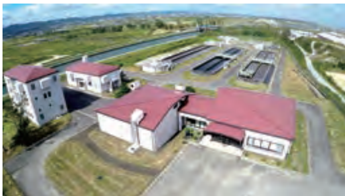
山元浄化センター（復旧後）
