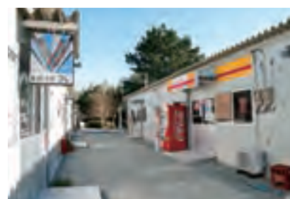
仮設店舗（町民グラウンド団地）
