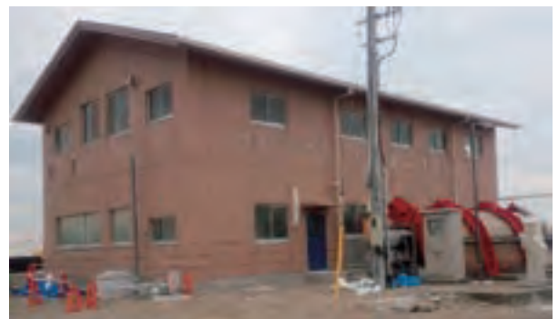
花笠第2排水機場
