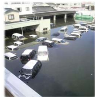
津波で浸水した東部土木事務所
