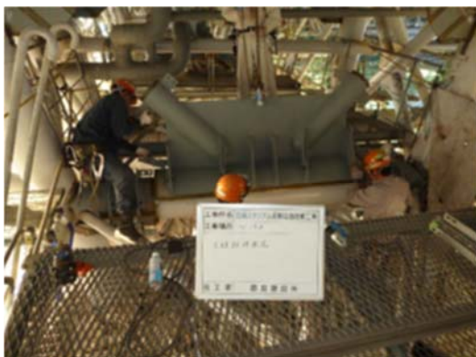
屋根T型梁の補強状況
