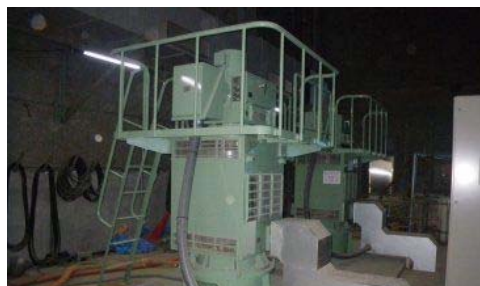
▲ポンプ設備全5台復旧完了
