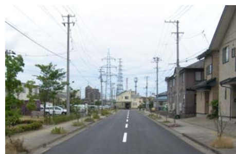
▲住宅地区の道路復旧後
