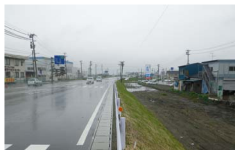
▲釜北線（その3）工事復旧後
