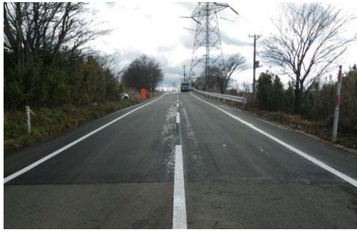
▲(国)457号（白石市福岡深谷即安）復旧後
