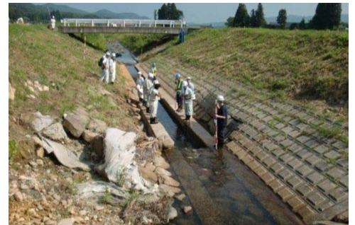
▲災害査定状況
