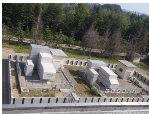
▲浸水対策完了
