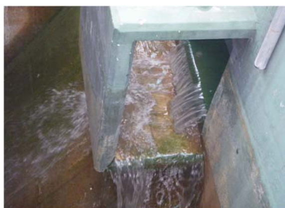
▲最初沈殿池 通水開始状況
