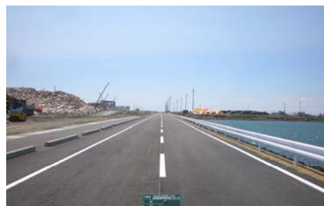
▲雲雀野中央線復旧後
