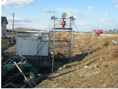
▲寺野警報所 復旧前 仮設の櫓にサイレン、スピーカ等を設置
