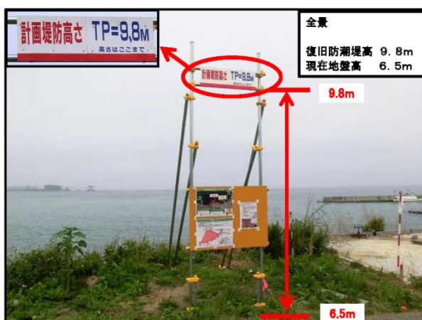
▲復旧高さ標示様子
