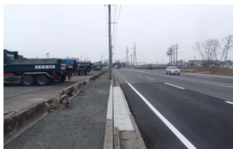
▲釜北線（その2）工事復旧後
