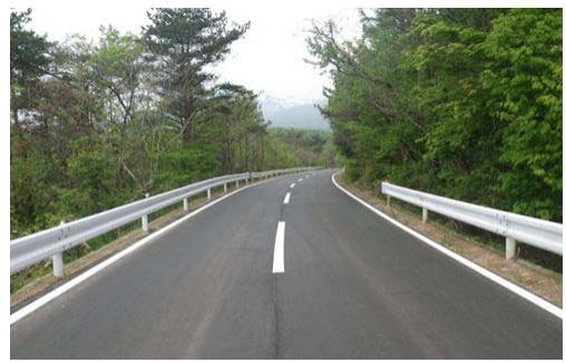
▲(主)南蔵王七ヶ宿線（白石市福岡二ノ萱）復旧
