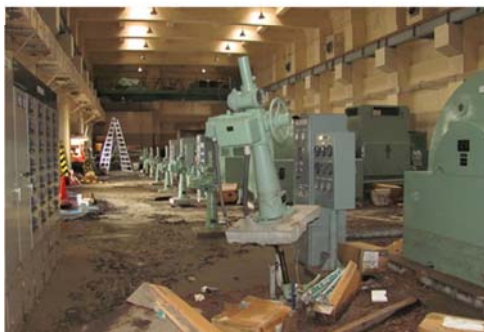
▲「送風機設備」被災直後 ガレキ・土砂流入状況
