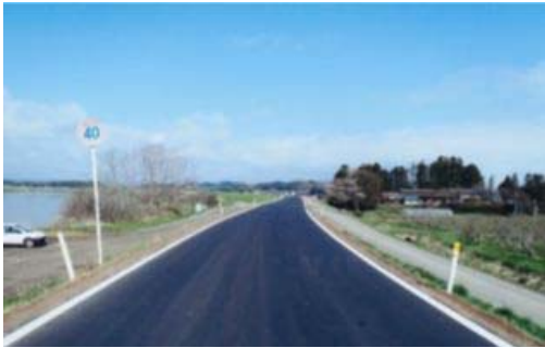
▲(主)丸森柴田線（角田市坂津田八反田）復旧後
