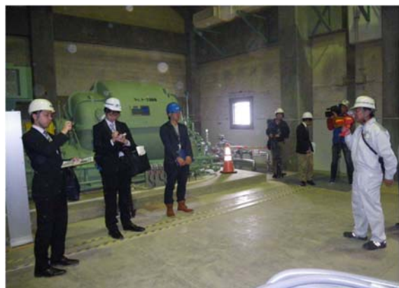
▲送風機施設公開状況
