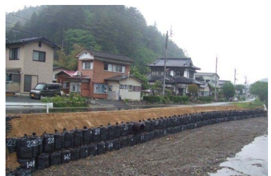
▲応急復旧完了（5 月 28 日）
