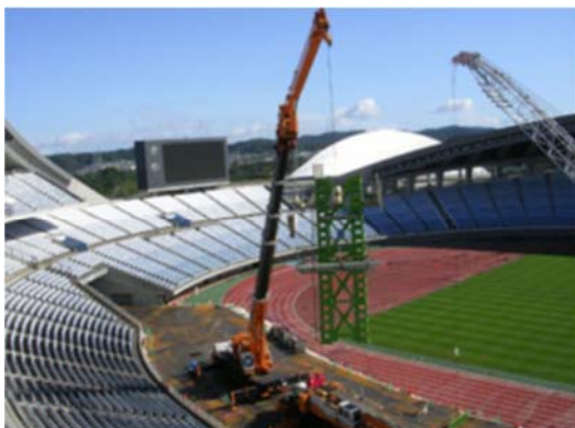
仮説柱の施工状況
