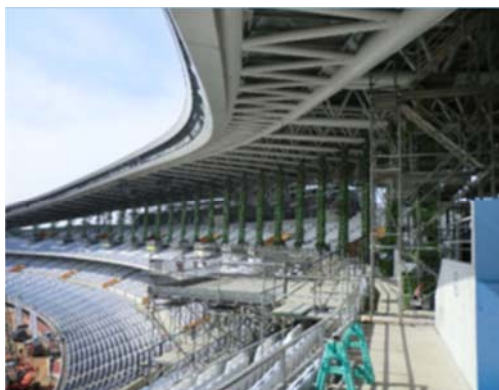
仮説柱の施工状況
