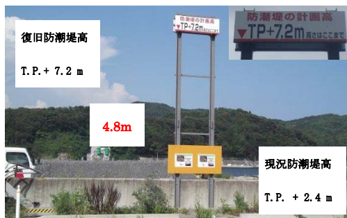
▲復旧高さ標示板設置
