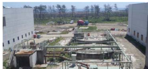
▲重力濃縮槽全3槽復旧完了
