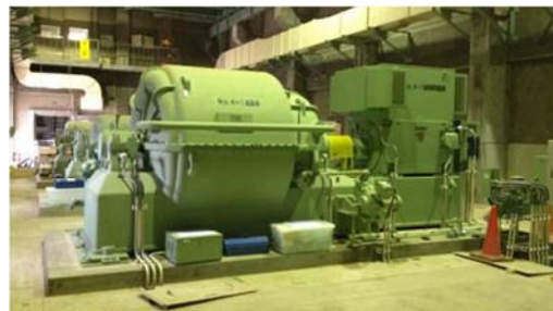
▲送風機設備復旧完了
