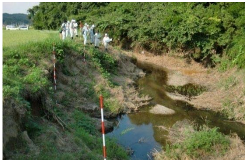
▲災害査定状況
