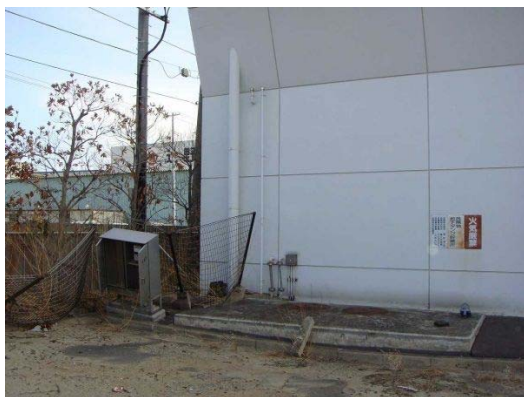
▲オイルタンク着工前
