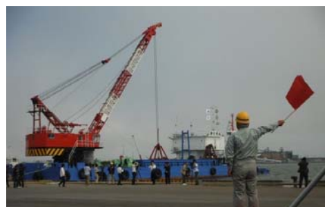
▲石巻港災害復旧工事着工式（着工の様子）
