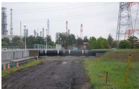
▲バイパス管接続状況
