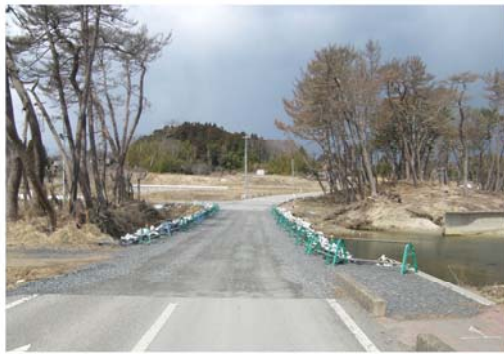
▲災害復旧応急工事完了後
