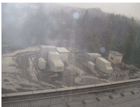
▲自家用発電機
