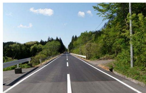
▲(国)457 号 (川崎町本砂金②) 復旧後
