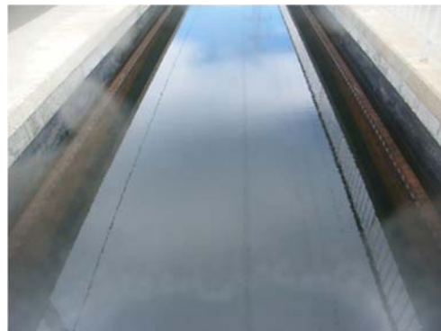
▲復旧完了 生物処理再開
