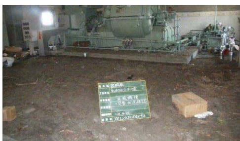
▲送風機設備被災後 ガレキ・土砂堆積状況
