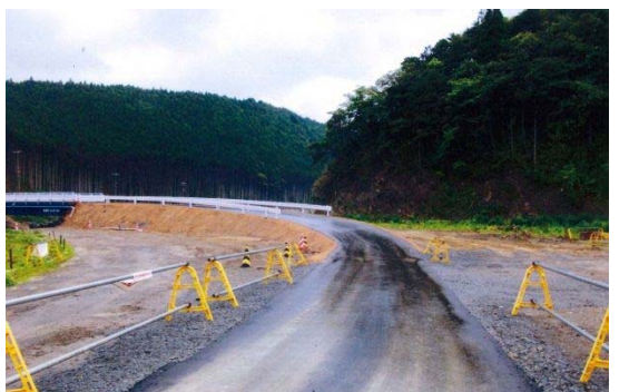
▲西戸橋復旧後
