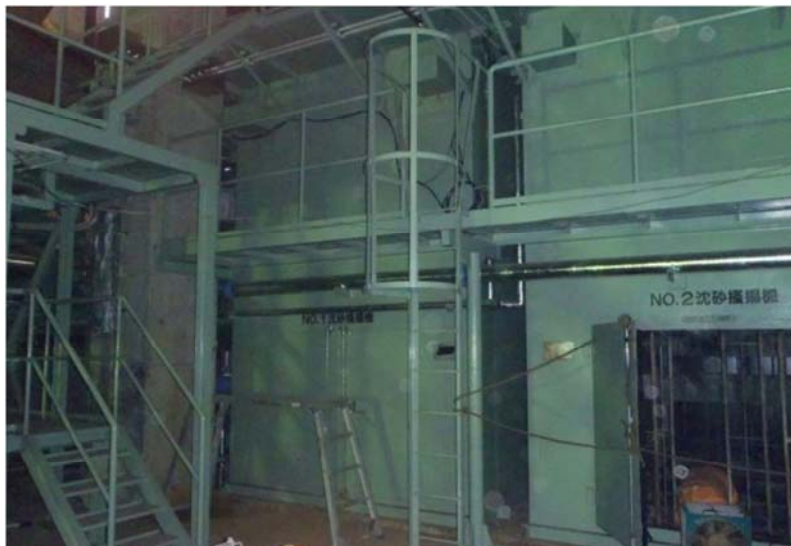
▲沈砂池設備沈砂掻揚機復旧状況
