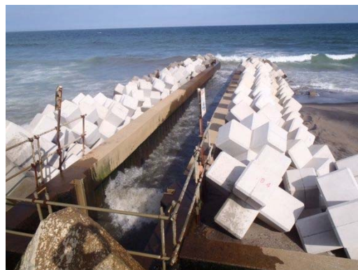
▲放流渠復旧状況
