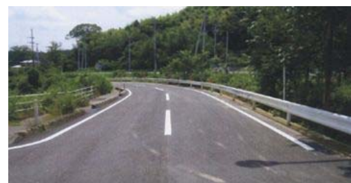
▲（国）113 号（丸森町石渕）復旧後
