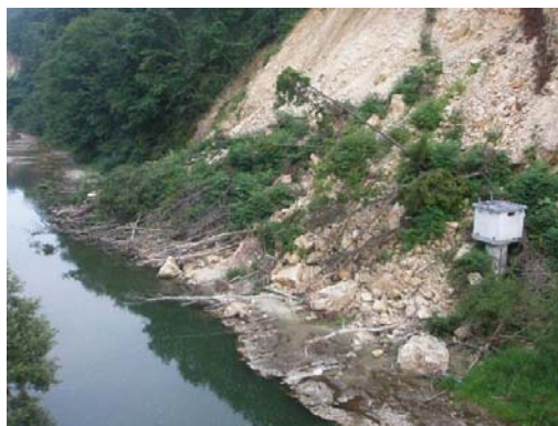
▲白沢河川水位観測所 復旧前 崖の崩落により観測所の機能停止
