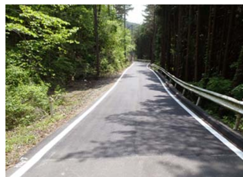
▲本復旧工事完了後
