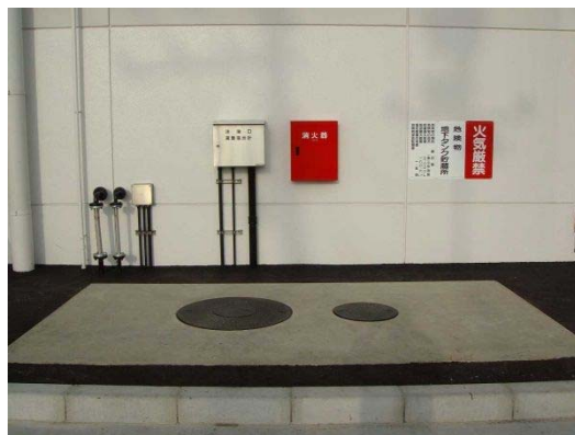
▲オイルタンク完成
