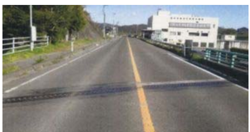
▲(国)349号（角田市江尻巻向）復旧後
