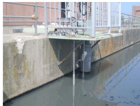
▲放流水質測定装置設置状況
