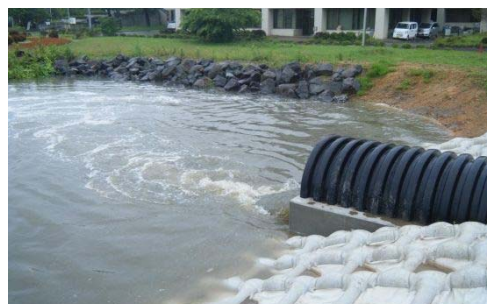
▲バイパス水路使用状況 「平成24年7月7日 大雨時」
