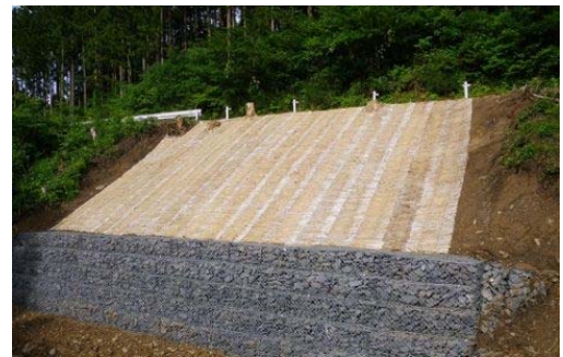
▲本復旧工事完了後
