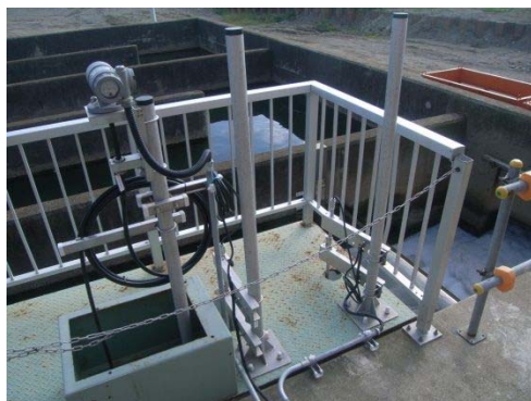
▲放流水質測定装置設置状況
