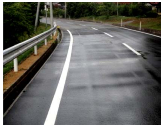
▲本復旧工事完了後
