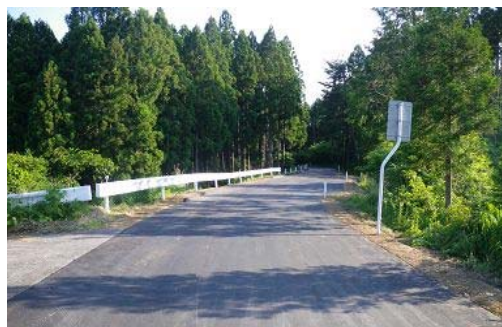
▲本復旧工事完了後
