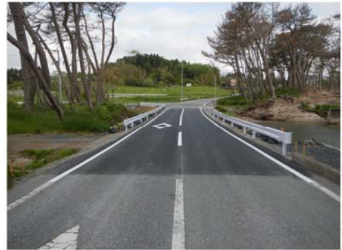
▲仮舗装工事完了後
