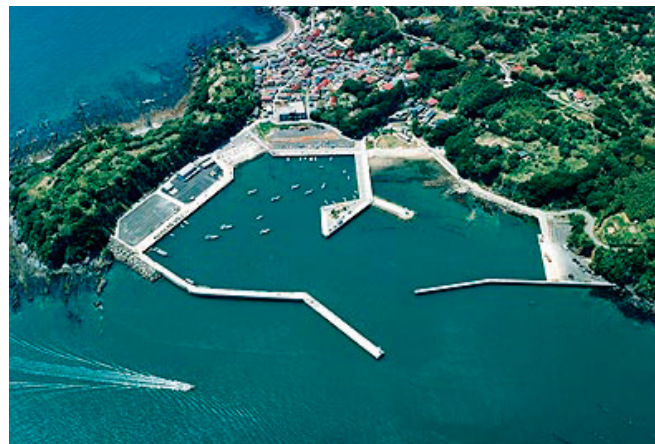
写真：仁斗田漁港の復旧状況（石巻市）
