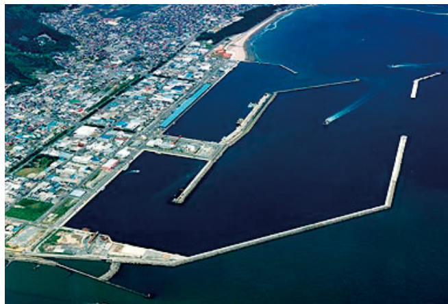
写真：石巻漁港の復旧状況（石巻市）
