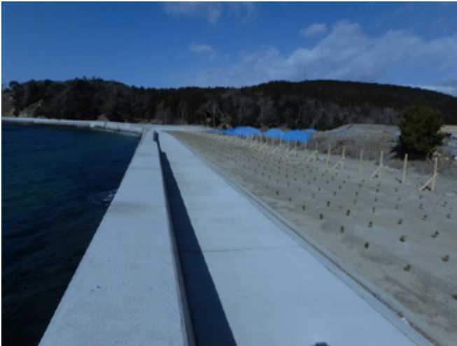
写真：復旧後の防潮堤と防災林予定地(石巻市白浜)
