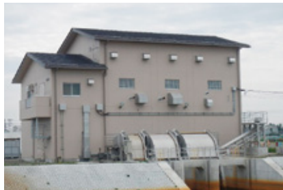
写真:大曲第二排水機場(東松島市)
