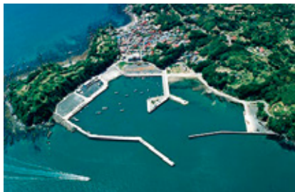
写真: 仁斗田漁港の復旧状況
