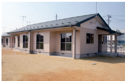
写真:災害公営住宅(栗原市)
