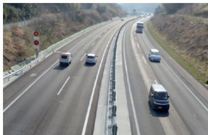
写真:4車線化した仙台松島道路
