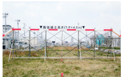
写真：門脇流留線 丁張設置（石巻市）
