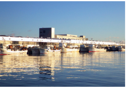
写真：復旧した石巻港
