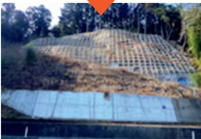
写真：完成後(平成26年度 法粋工・土留工)
