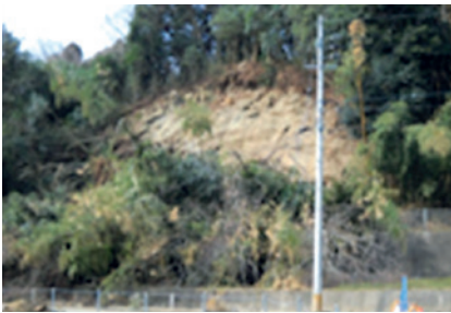
写真：被害状況(平成23年3月 県道閉塞[東松島市])
