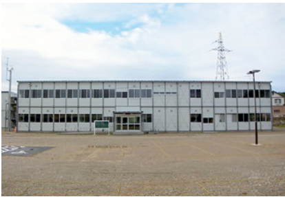
写真:気仙沼警察署仮庁舎
