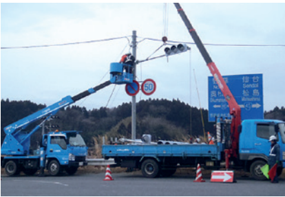
写真:信号灯器のLED化改良
