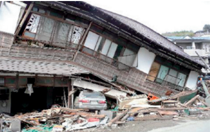
写真：倒壊した家屋（気仙沼市）
