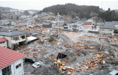
写真：津波が押し寄せる様子（南三陸町）
